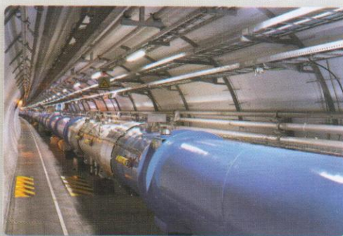
Figura C Il tunnel di LHC. I fasci di particelle viaggiano all'interno dei moduli rappresentati che producono il campo magnetico necessario per mantenere le particelle in moto su un'orbita circolare.
